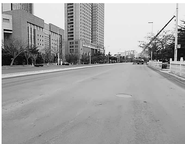
▲道路工事の様子
